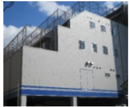
<平成25年12月増築棟完成>
